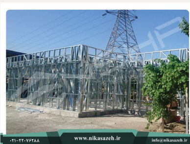
ساختمان اداری پست برق
