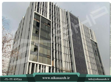
پروژه برج فناوری شریف
